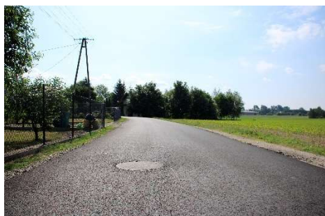
Kanalizacja sanitarna w miejscowości Dęby
