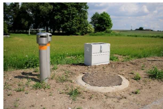
Kanalizacja sanitarna z przykanalikami w miejscowości Dęby
