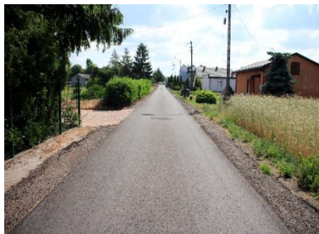
Zmodernizowana droga gminna Smarglin - Dobre
